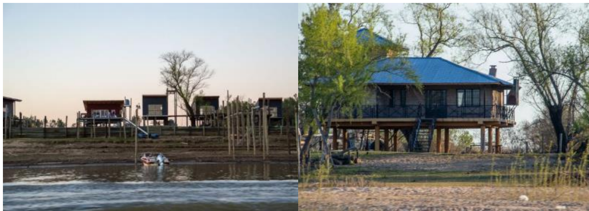
Arquitectura palafítica con troncos o con columnas de hormigón armado
